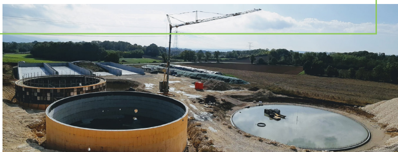
Construction d'une unité de biométhane à Saint Victor de Morestel
