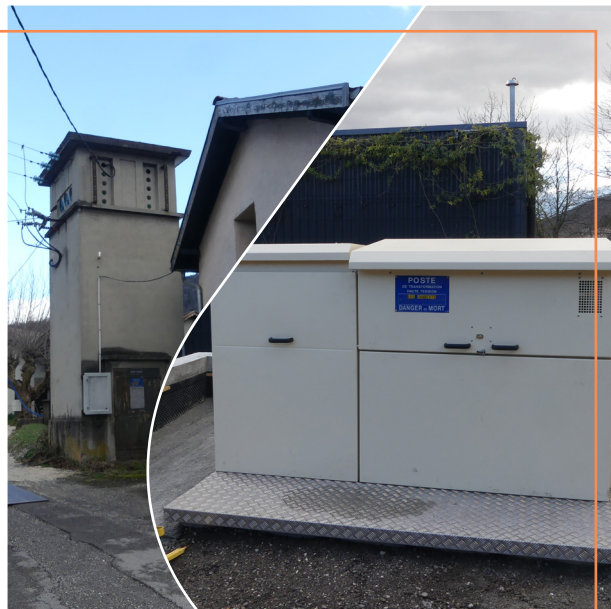
Remplacement d'un poste électrique à Jarrie
