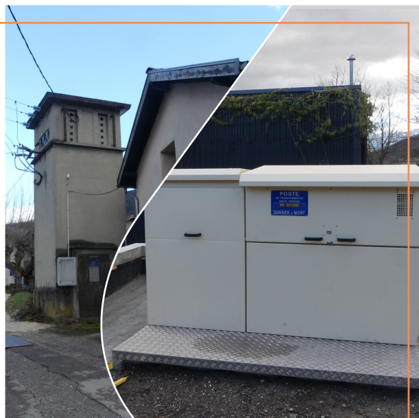
Remplacement d'un poste électrique à Jarrie
