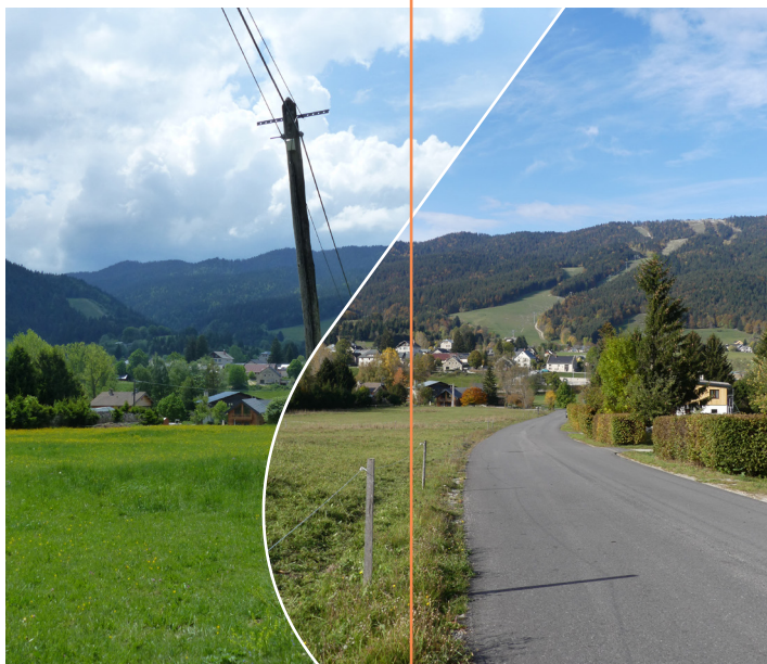
Enfouissement de réseaux et réalisation du génie civil à Méaudre, puis délégation à Orange.
