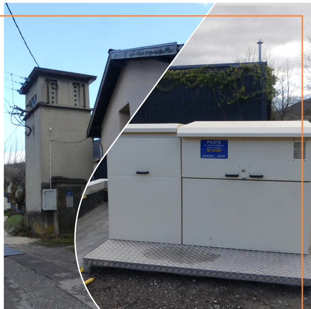
Remplacement d'un poste électrique à Jarrrie
